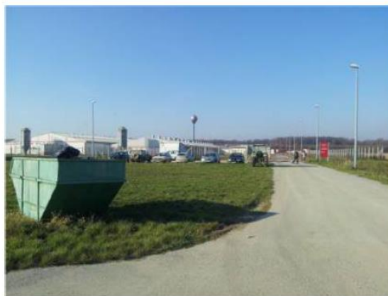
Slika 31. Objekti farme na lokaciji zahvata.
